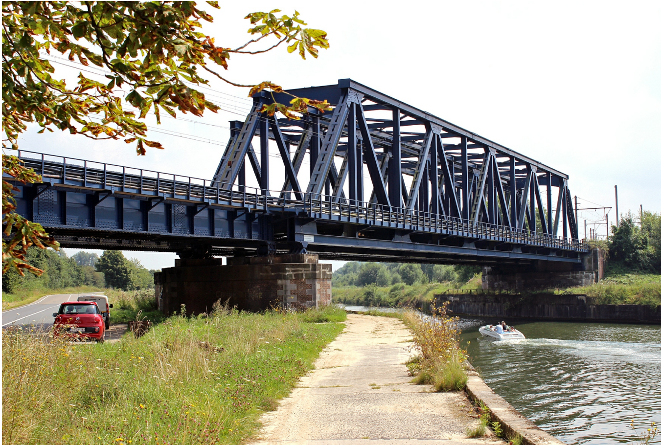
LUTTRE (Belgique – Hainaut), pont de chemin de fer sur le canal Charleroi-Bruxelles.
