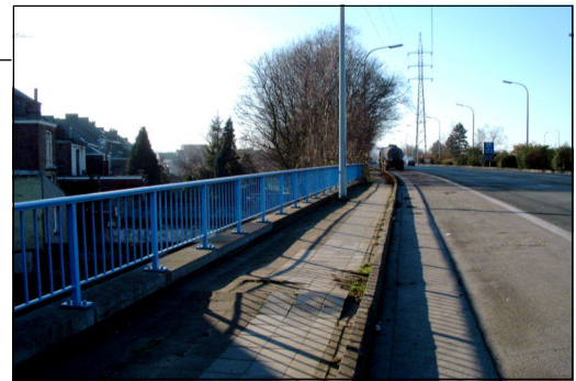
La rocade qui longe la Sambre à Châtelet, photographie, octobre 2000.
